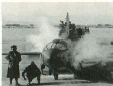
ベルX-1。'47年10月14日、高度4万2千フィートでマッハ1.015を達成、初めて音速の壁を破った。
